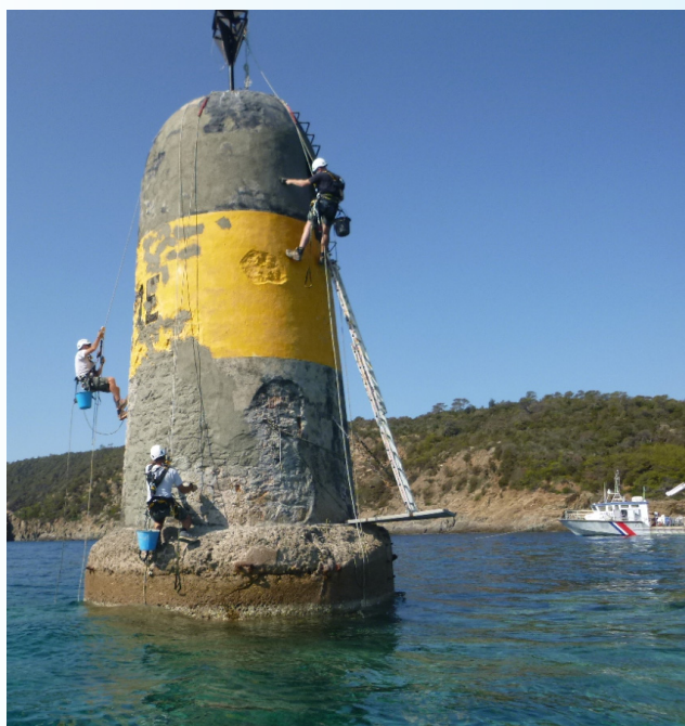
Chantier de rénovation de la tourelle de la Crède à Bandol
