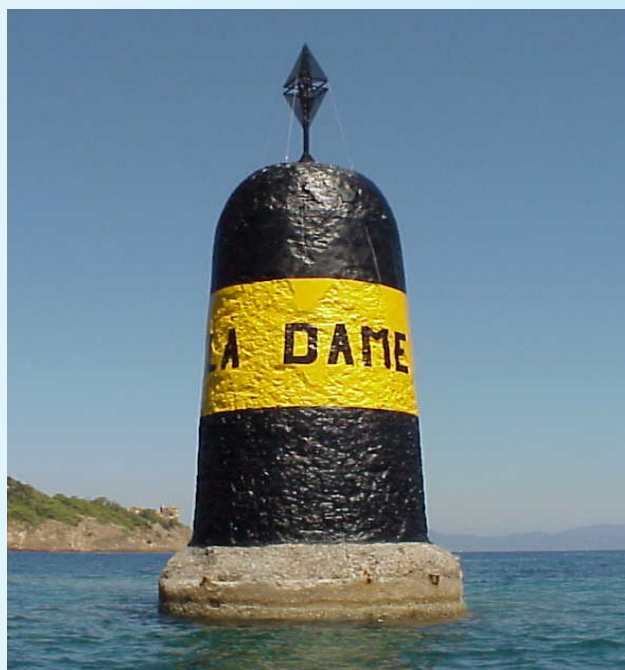
Chantier de rénovation de la tourelle de la Dame, Port-Cros
